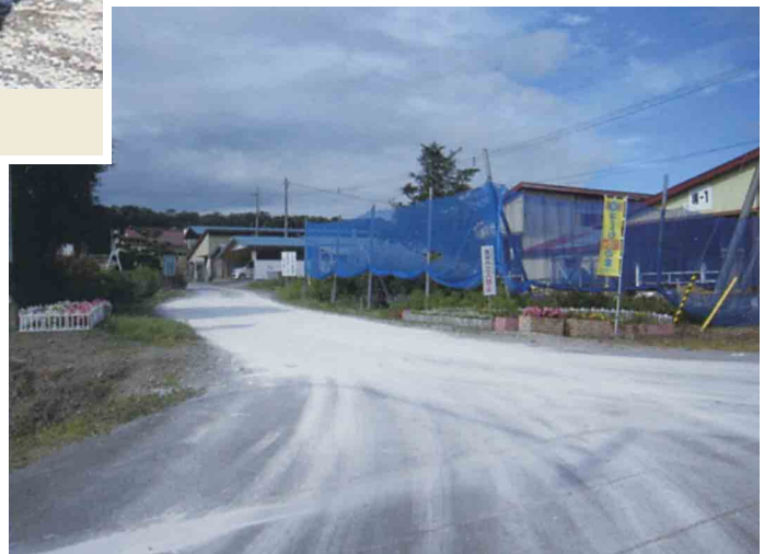
消石灰帯の設置
